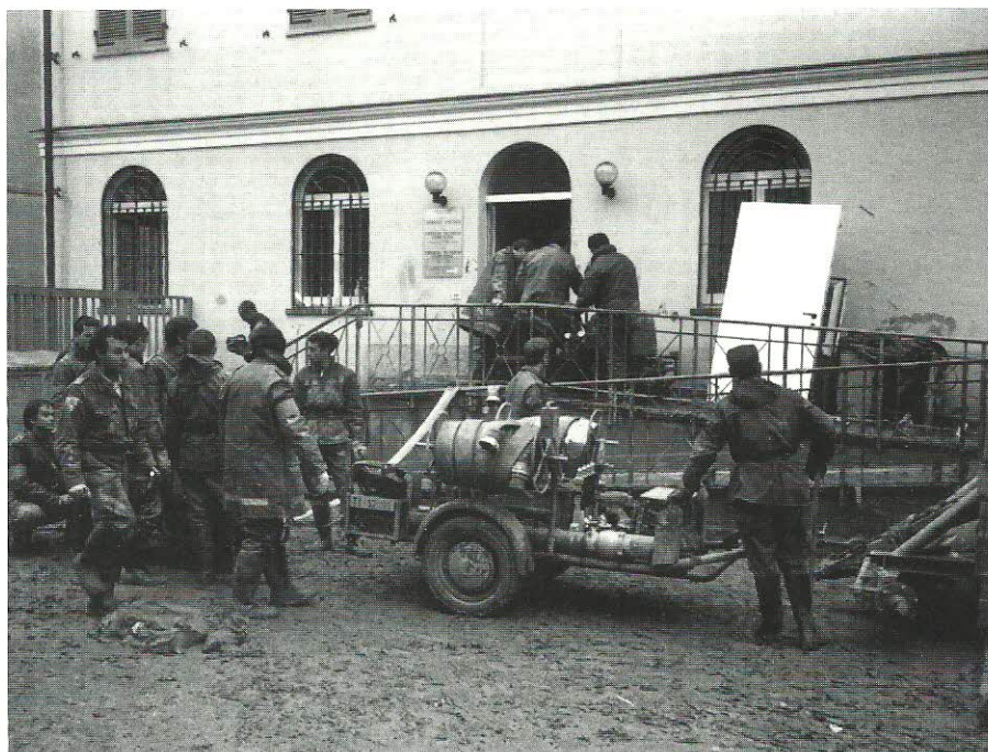
Canelli, intervento alla biblioteca comunale
