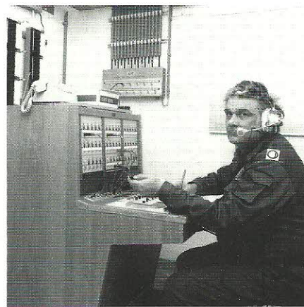
La centrale telefonica
