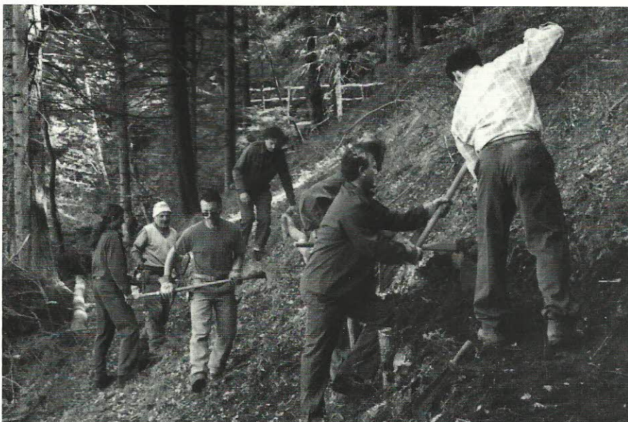
Una fase dei lavori di sistemazione
