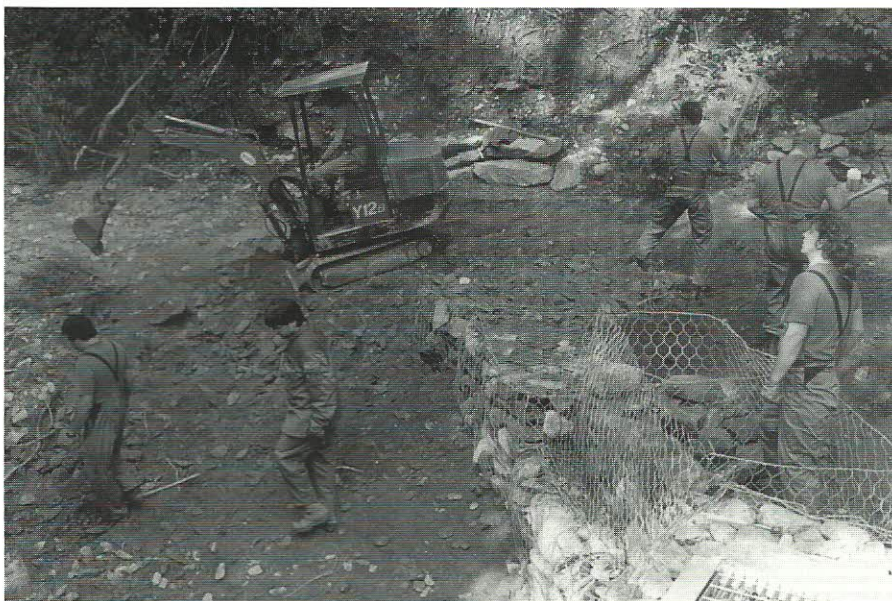
La risistemazione delle zone danneggiate
