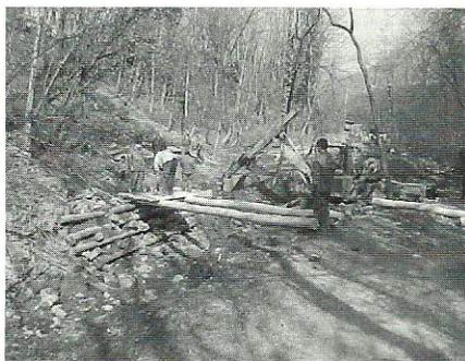
Con il rifacimento degli argini e la pulizia dell'alveo del torrente i militi hanno pure effettuato lavori sul sentiero che percorre la piccola valle ed alla sostituzione di un ponte pedonale, al risanamento delle scarpate e alla manutenzione di altri manufatti.
