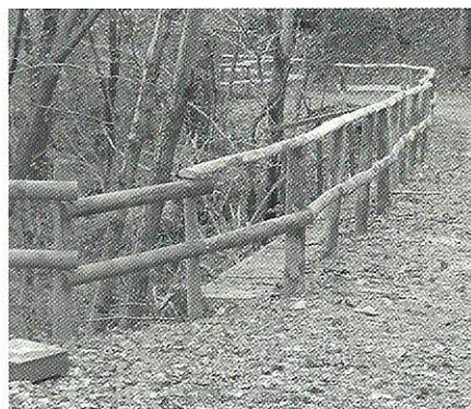
Il lavoro svolto dal gruppo impiegato a Tesserete
